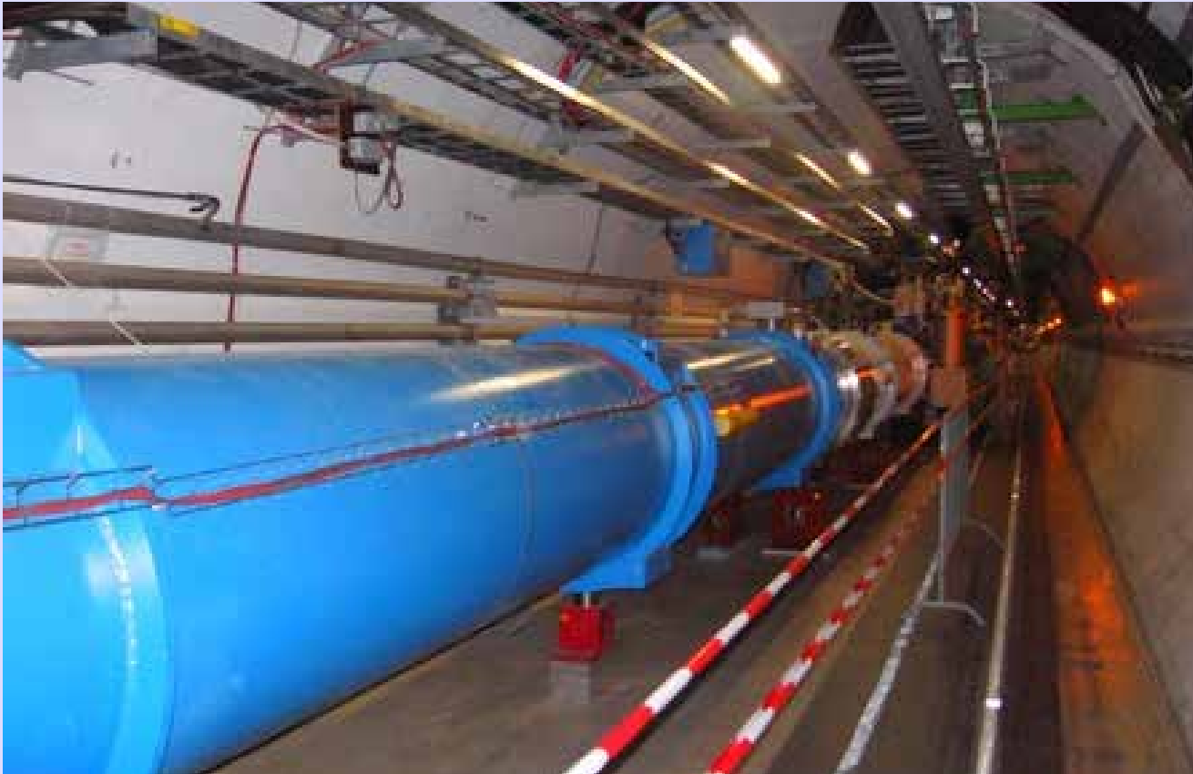
Tunel Wielkiego Zderzacza Hadronów ze wszystkimi magnesami i instrumentami gotowymi do użycia
